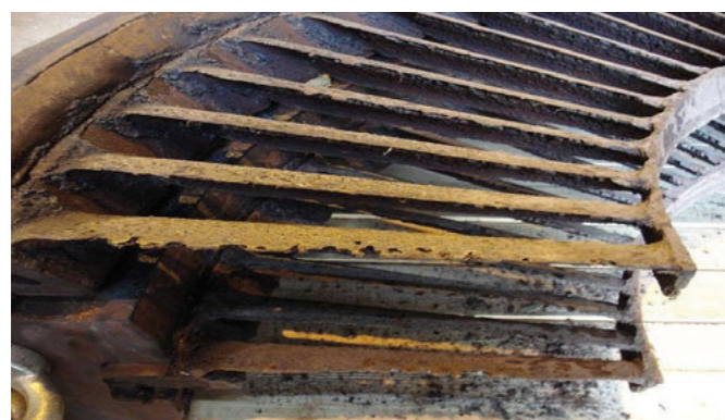
▲ Lopatky turbíny poškozené korozí
